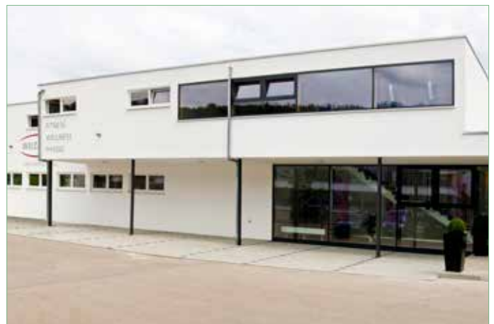
Erweiterung eines Fitness- und Rehasstudios.
