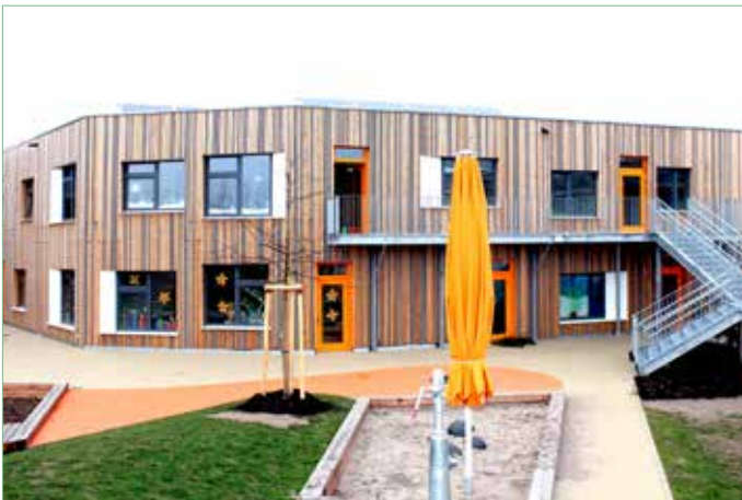
Neubau einer Kindertagesstätte Bahnstadt Heidelberg.
